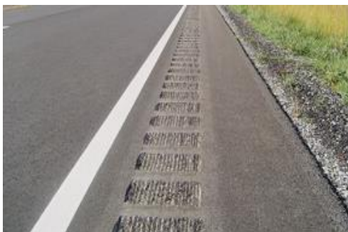
Зураг 6. Авто замын захын хэсэгт байрлуулсан шуугиант тууз харуулав.
