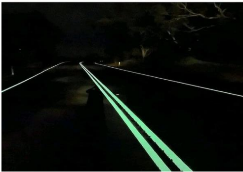
Зураг 7. Замын тэмдэглэл шөнийн цагт гэрэлтэж байгаа байдал
