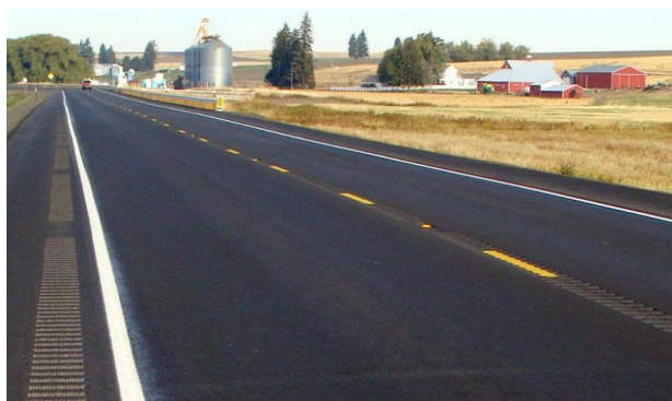
Зураг 5. АНУ-ын мужийн замуудад байрлуулсан шуугиант туузыг харуулав
